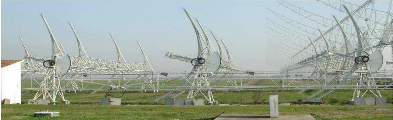
L'asse di rotazione della singola antenna N/S è posto in direzione Est/Ovest, consentendo la sola rotazione del cilindro parabolico lungo il senso Nord/Sud. Lo specchio del cilindro parabolico è formato da una serie di fili metallici di 0,5 mm di diametro, posti parallelamente uno all'altro ad una distanza di 20 mm. Al centro di ogni cilindro parabolico vi è la linea focale, che contiene 64 dipoli ciascuna.
