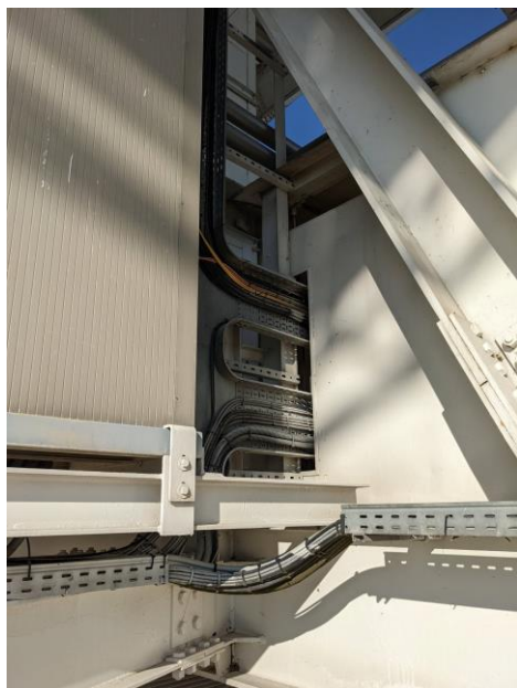
Figura 9-4 Uscita cavi da catena di azimut e passerella sotto a prefabbricato di Medicina (BO) come esempio
