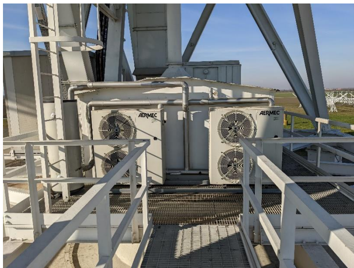
Figura 13-3 Posizionamento indicativo macchine frigorifere a Medicina (BO)
