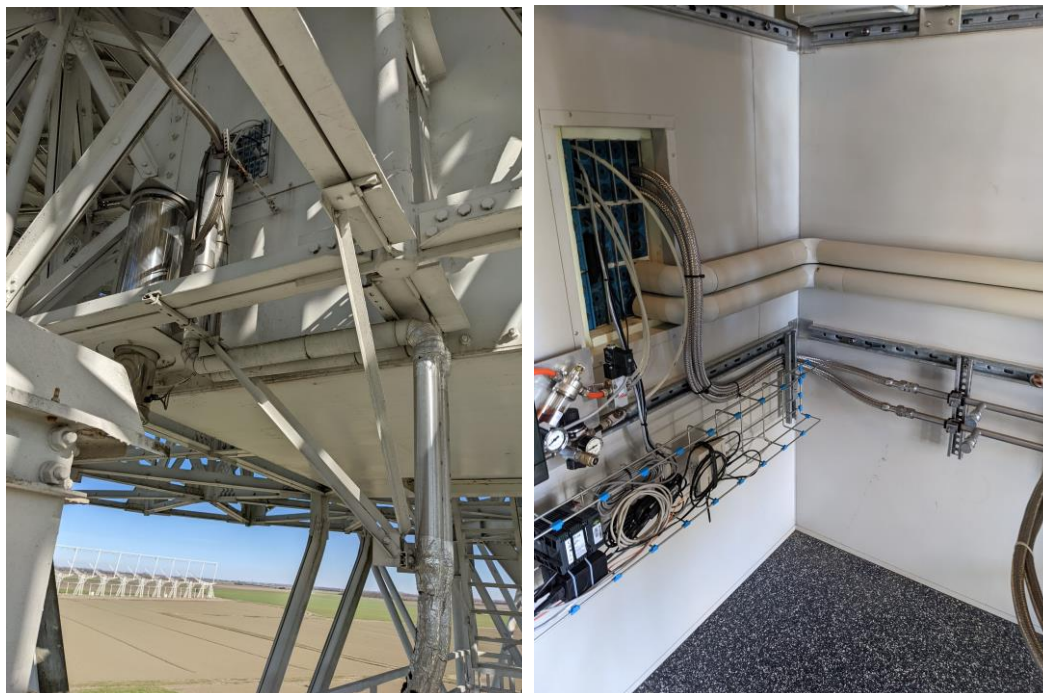
Figura 9-3 Ingresso tubi e cavi nella V.E.R. Vertex Equipment Room tramite Roptec
