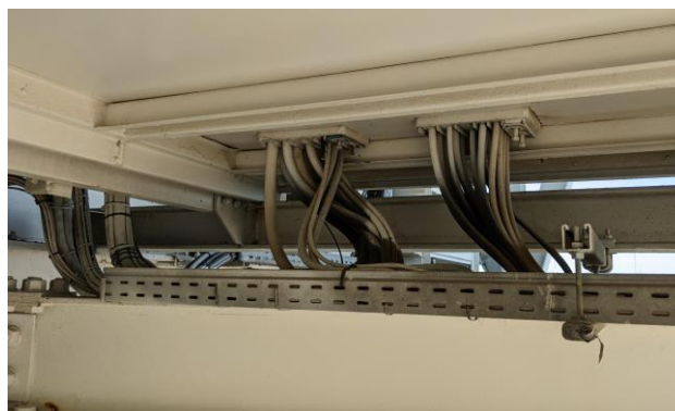
Figura 9-4 Uscita cavi da catena di azimut e passerella sotto a prefabbricato di Medicina (BO) come esempio
