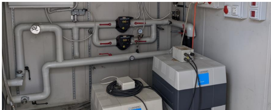
Figura 13-5 Compressori criogenici e relativo impianto raffreddamento acqua a Medicina (BO) N.B. a Noto verrà implementata una sola pompa di circolazione acqua
