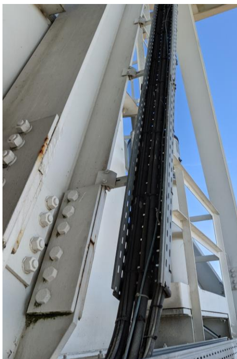
Figura 9-1 Esempio di posa canale portacavi
