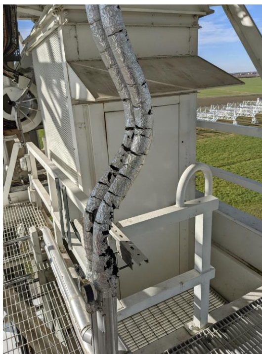
Figura 13-4 Linee flessibili acqua refrigerata nel punto di snodo elevazione
