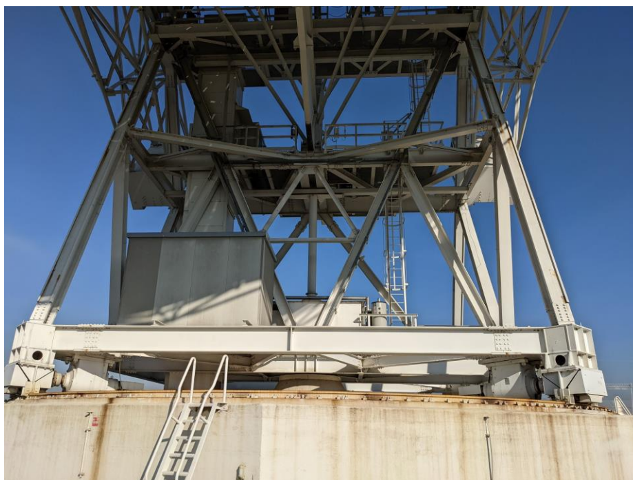
Figura 8-1 Posizionamento indicativo del prefabbricato A.E.R. sull'antenna di Medicina (BO); a Noto ce ne sarà uno speculare denominato C.E.R.
