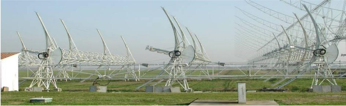
L'asse di rotazione della singola antenna N/S è posto in direzione Est/Ovest, consentendo la sola rotazione del cilindro parabolico lungo il senso Nord/Sud. Lo specchio dell'antenna è formato da una serie di fili metallici di 0,5 mm di diametro, posti parallelamente uno all'altro ad una distanza di 20 mm.
