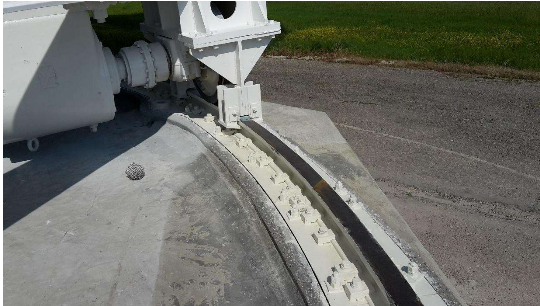
Figura 4 Gruppo ruota motrice – riduttore e rotaia installati
