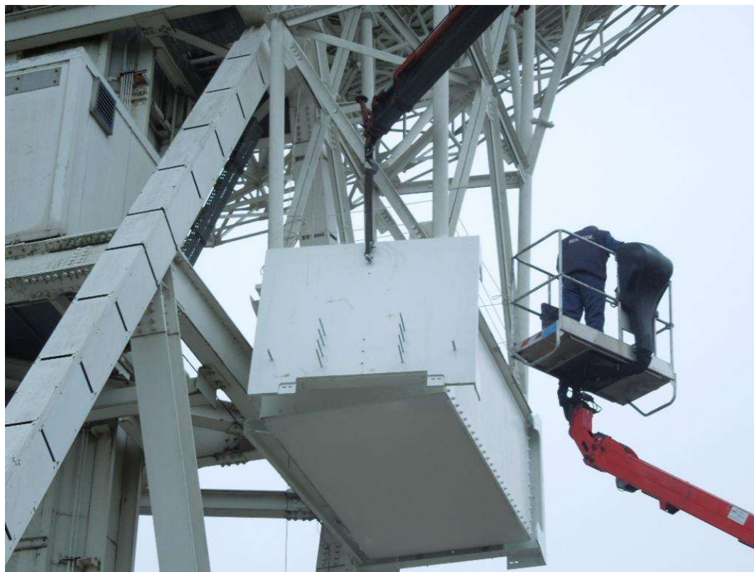
Figura 6 Installazione contrappesi
