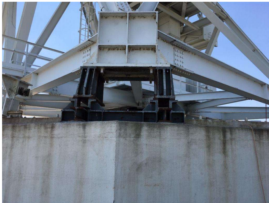
Figura 2 Completo sollevamento antenna – Gruppo ruota rimosso
